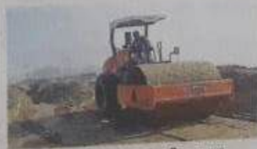
बाइपास पर पुल निर्माण कार्य में लगे कर्मी • जागरण
