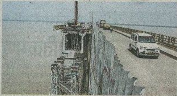
पाया संख्या 17 के पास काटा जा रहा स्पैन • जागरण
